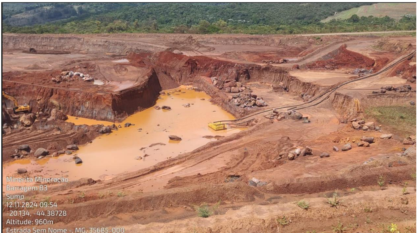
Minerita Mineração Barragem B3 Reservatório em retomada 12.11.2024 09:54 -20.13396, -44.38727 Altitude: 960m Estrada Sem Nome -, MG, 35685-000
