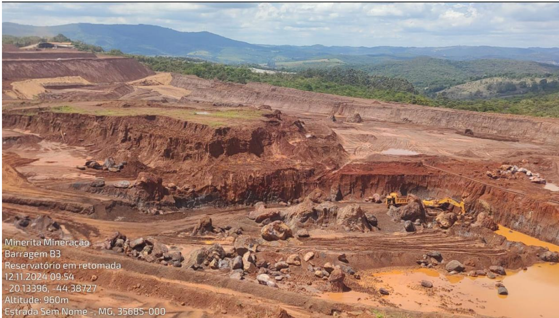
Escavação realizada por conjuntos escavadeiras e caminhões basculantes.
